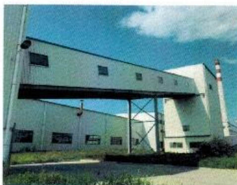
原料输送带密封除尘降噪
