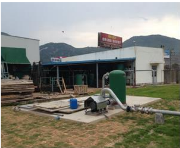
循环水废水沉淀池
