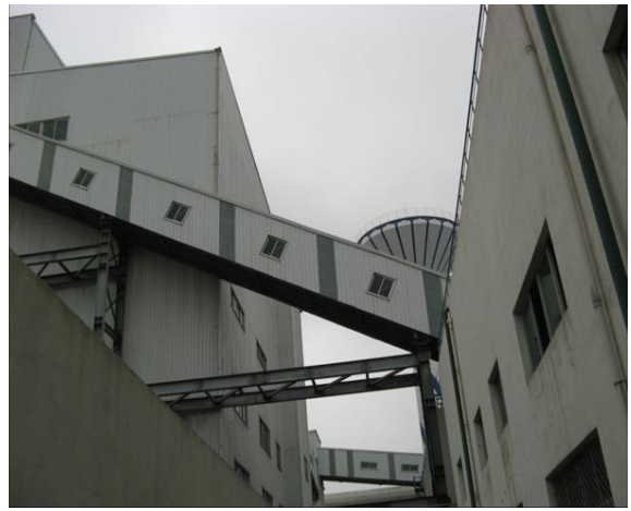
原料输送带密封除尘降噪
