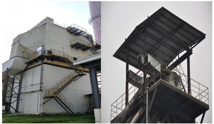
脱硝设施密封除尘降噪及消声器
