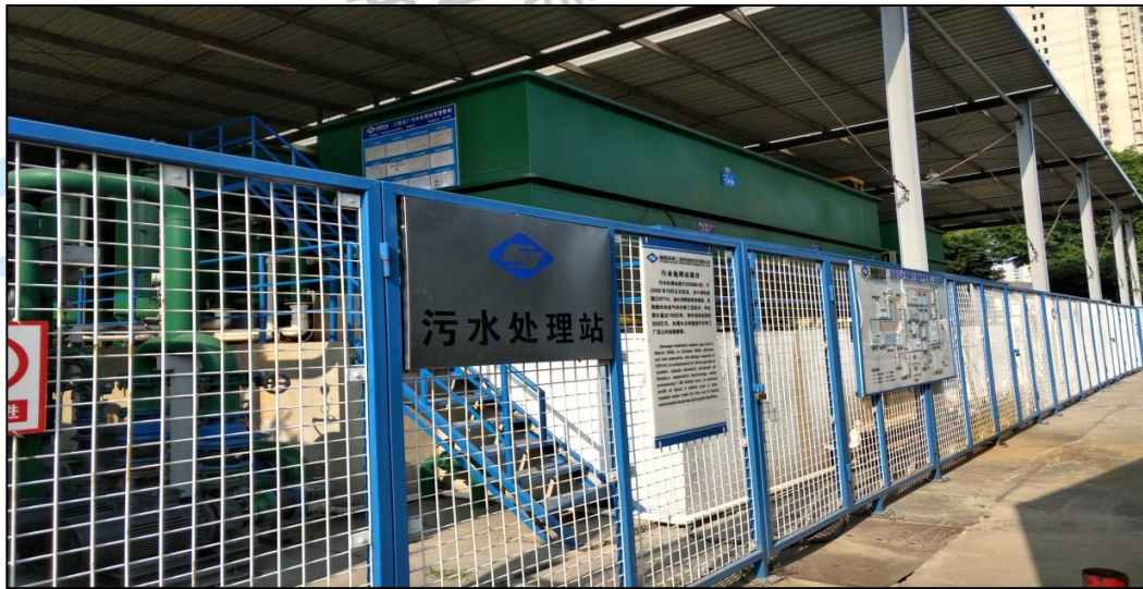
玻璃污水回用处理站
