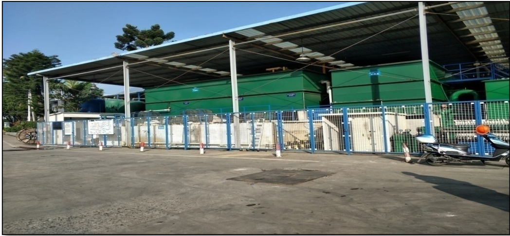
制造五厂区事故应急池建成照片
