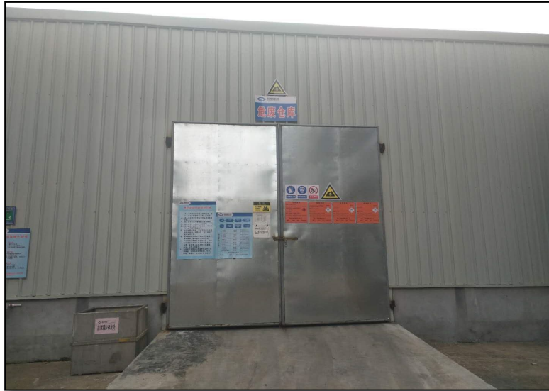
危废暂存场所
