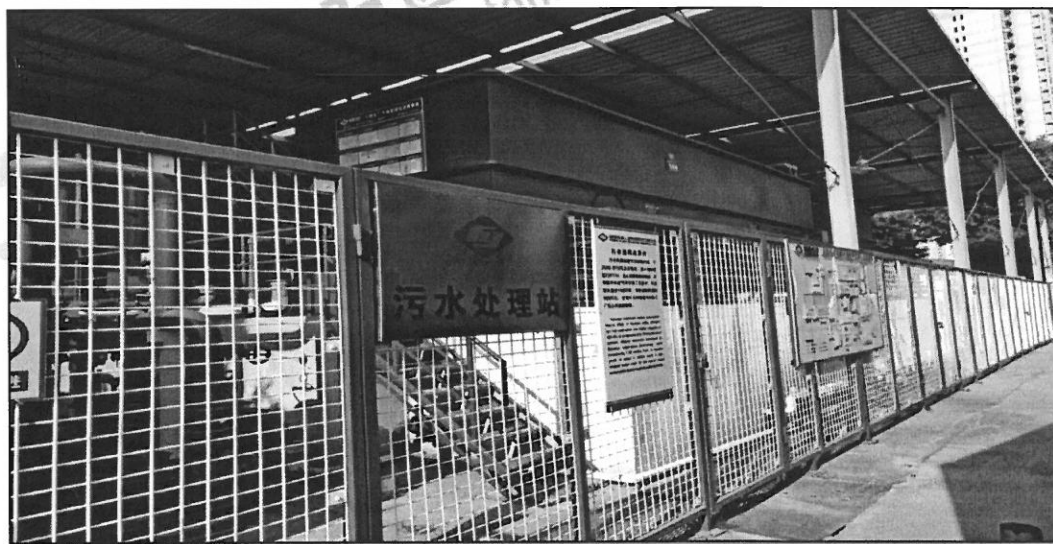
玻璃污水回用处理站
