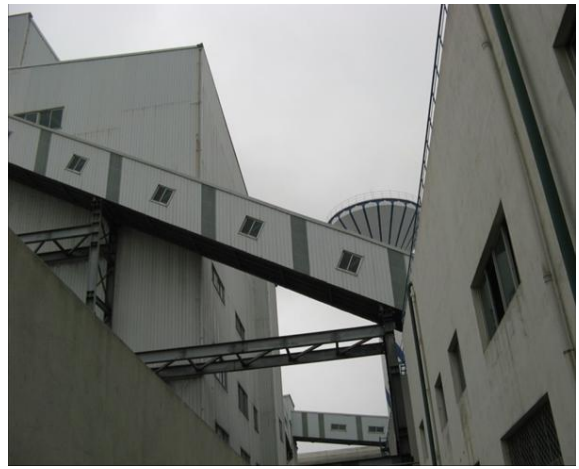
原料输送带密封除尘降噪
