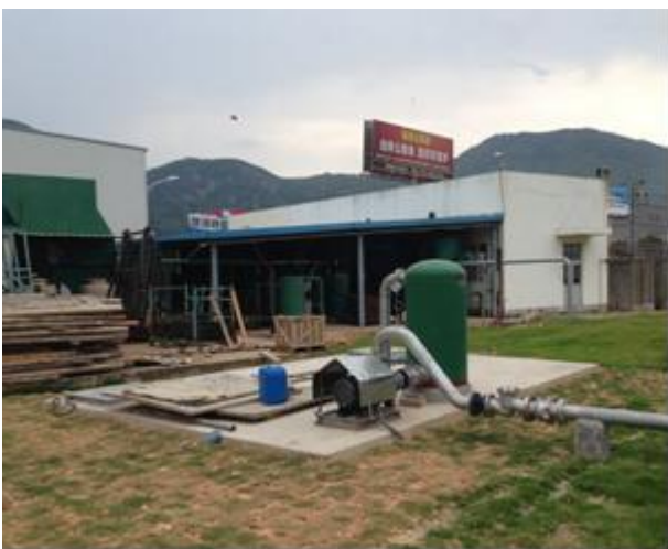
循环水废水沉淀池
